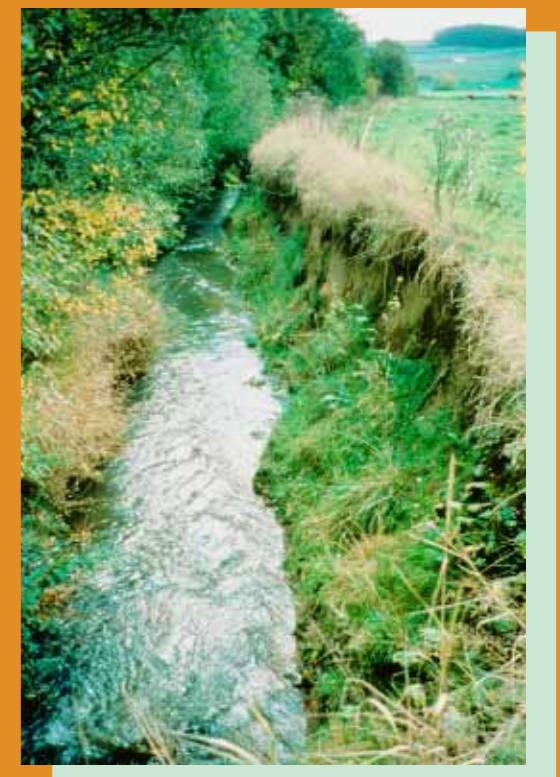
weitere Eintiefung, Destabilisierung und Aufweitung der Ufer
