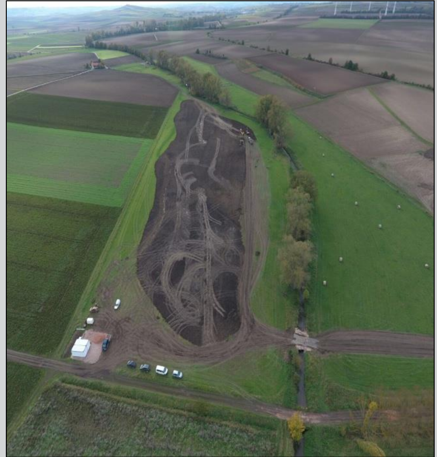
F.G Erdbau GmbH, 2017
